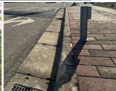
③立柱式反光板 反射車燈以達到光學警示效果
