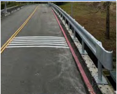
②聲音警示減速標線 同時達到警示石虎及用路人
