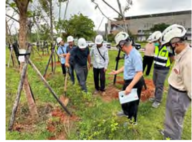
工程施工查核
