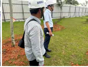
現場定期工地督導
