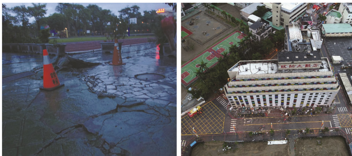
圖六 明禮國小以及統帥飯店的破壞情形
