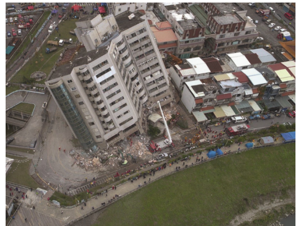
圖二 花蓮地震造成周遭建築物損毀
