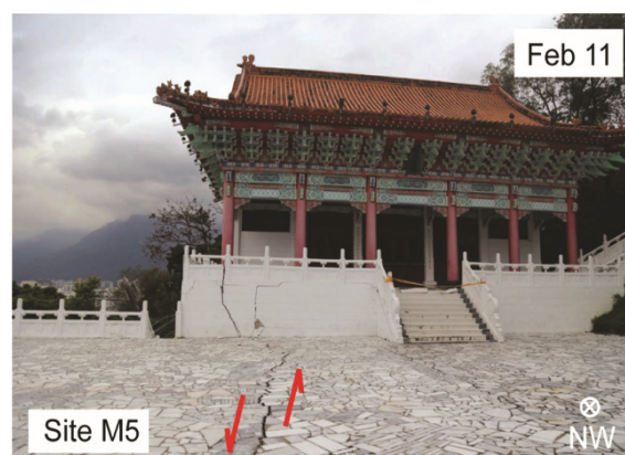
圖五 忠烈祠周遭的錯動(Huang et al., 2018)
