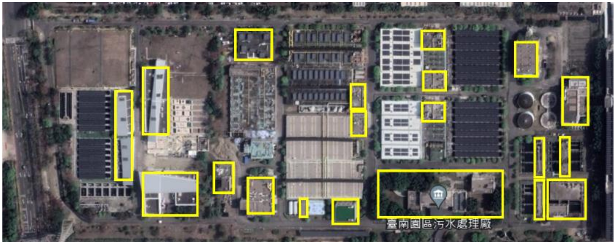
圖 1 臺南園區污水處理廠一廠建物
