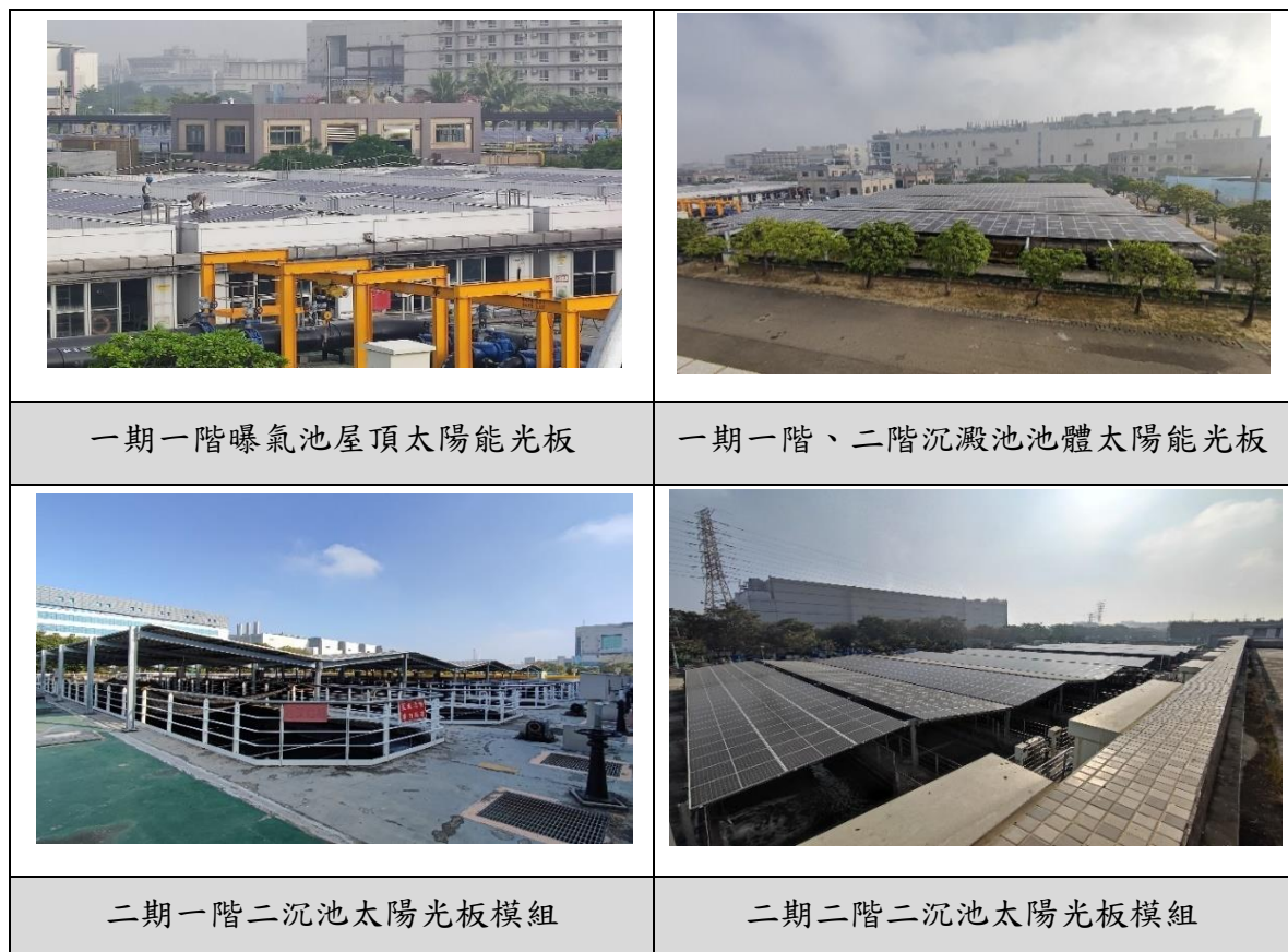
圖 4 增設太陽光電發電系統
