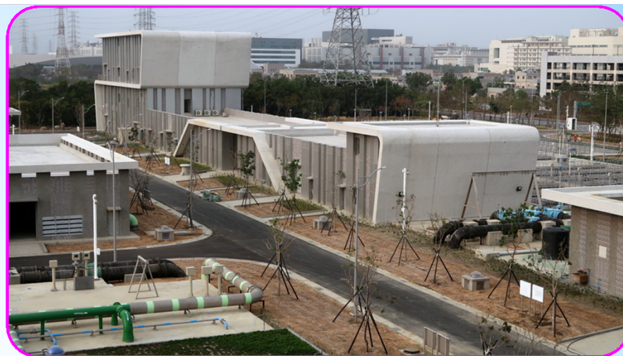
土木工程-建築物/建築裝修
