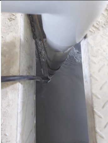
進流泵放置於迴流/廢棄污泥槽
