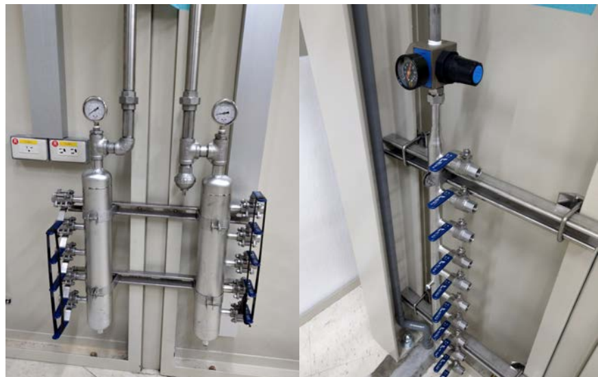
圖 2.37：07A1 實驗站輻射屏蔽屋內冷卻水與高壓空氣分配器
