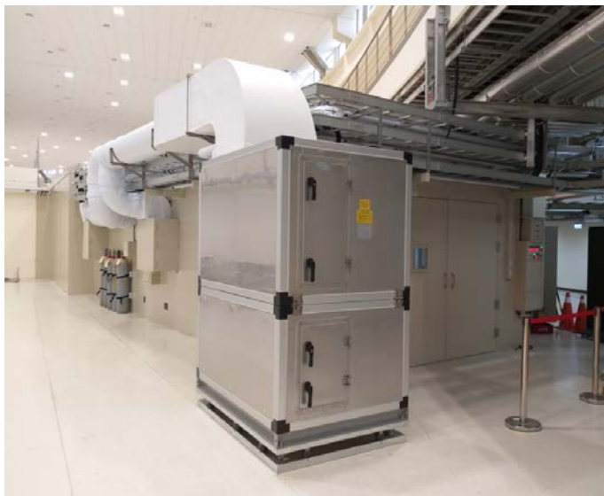
圖 2.38：07A1 光束線輻射屏蔽屋之冷卻水、壓縮空氣、排氣設施及溫度控制箱
