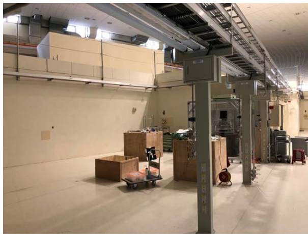
圖 2.46：TPS 27A 輻射屏蔽屋及光束線水氣電系統
