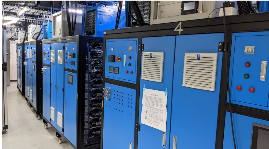
完成 300kW SSPA 高頻發射機
