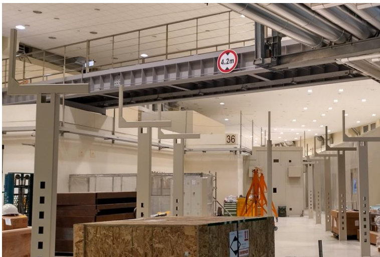
圖十四、輻射屏蔽屋基礎主體、光束線水氣工程線路用支架
