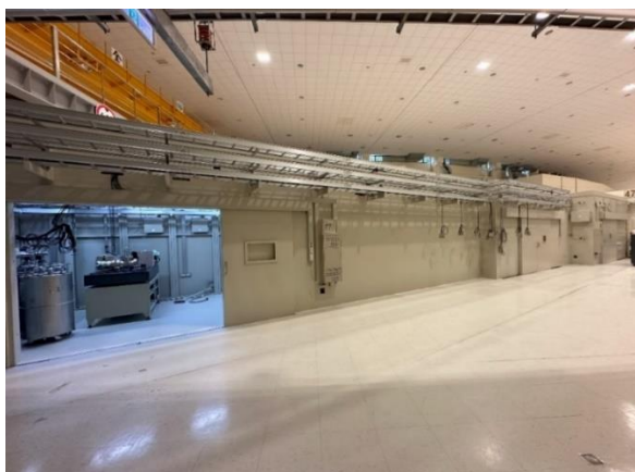
圖五一、輻射屏蔽屋、電力與照明消防設施建造完成
