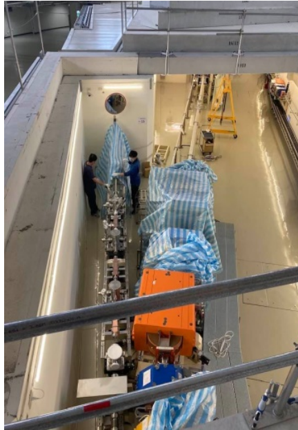
圖 2.67：開啟 TPS 隧道蓋板，將前端區真空系統吊入
