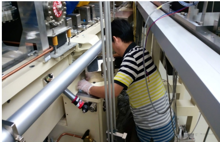
圖 2.36：全環支架下墜防護螺栓安裝作業
