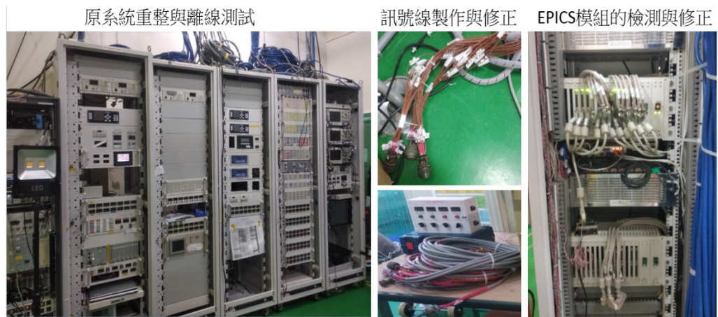
圖 2.24：實驗室-SRF 模組水平測試用電子控制及監視系統的重整。
