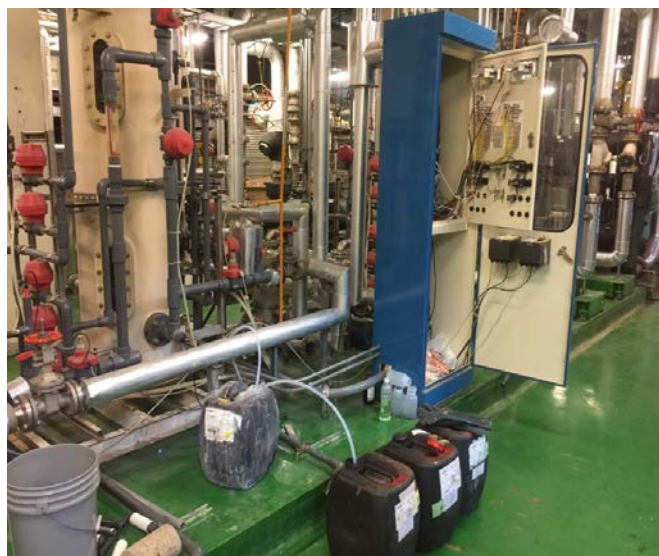
圖 2.11：TLS BL & SRF 去離子水系統混床樹脂單元再生
