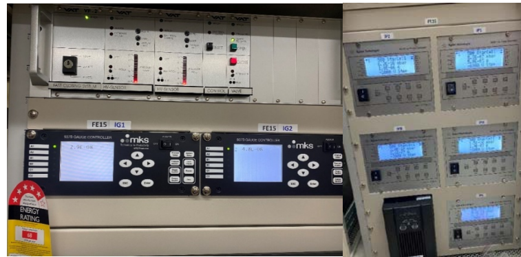
圖 2.68：前端區離子幫浦氣壓讀值正常(左)；Cold Cathode Gauge 氣壓讀值正常(右)
