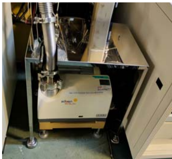
圖七、Septum 差分抽氣使用之 dry pump 加裝金屬屏蔽
