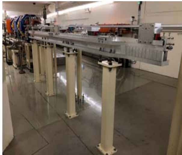
圖十二、完成 TPS SR22 EPU 腔體支架安裝及定位
