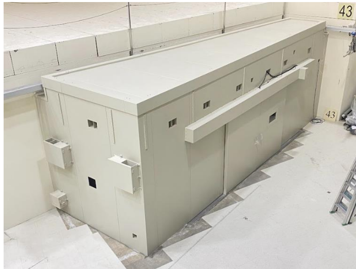
圖十五、輻射屏蔽屋已完工
